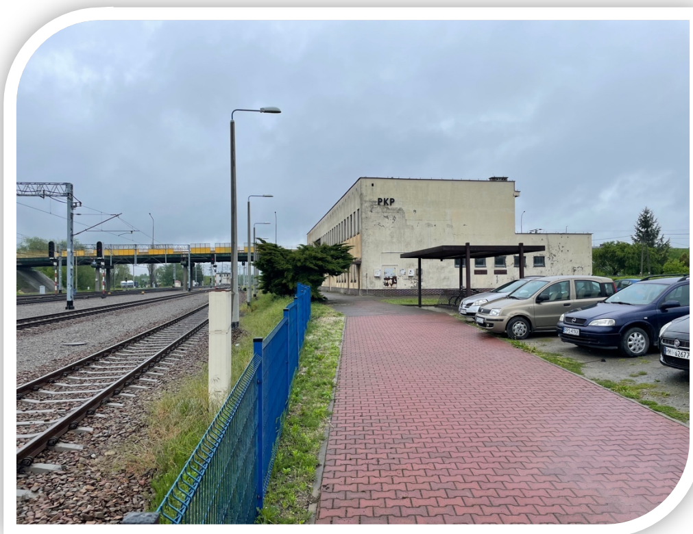
Fotografia 9. Ropczyce - dworzec kolejowy
